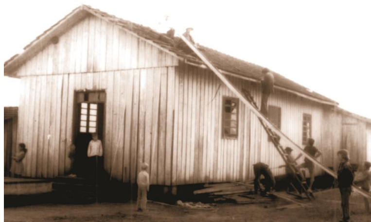
Figura 16 - Igreja Católica do distrito de Itacorá sendo desmanchada para construção de outra mais ampla
